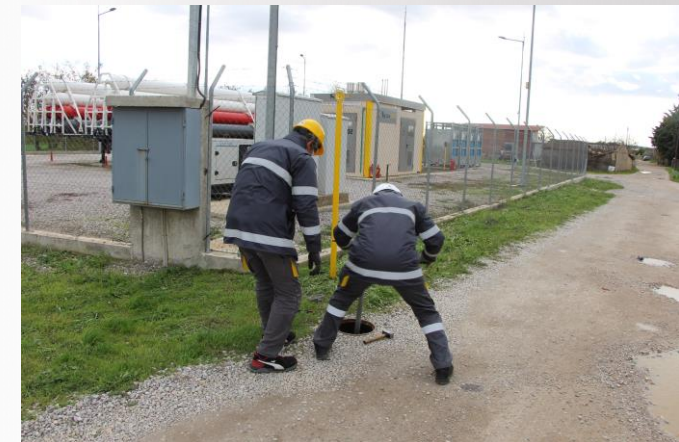
Τεχνική Επέμβαση στο σταθμό CNG Κουφαλίων
