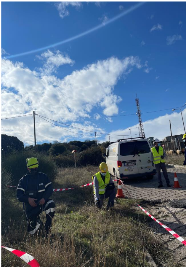
Έλεγχος Διαρροής στο City Gate Ασβεστοχωρίου
