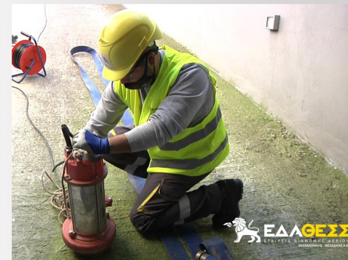
Αντληση υδάτων από το Υπόγειο των Γραφείων της ΕΔΑ ΘΕΣΣ
